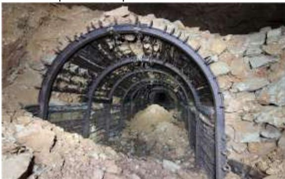
Figure 5 : Boisage mixte, mine de zinc, plomb, cadmium, cuivre
